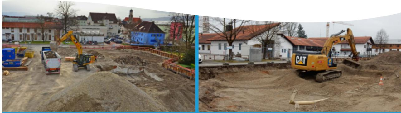
Zwei Spezialfirmen richten die Baustelleninfrastruktur für die Altlastensanierung ein. Dafür stellen sie u.a. Bagger- und Bohrgerät sowie Baucontainer auf.
