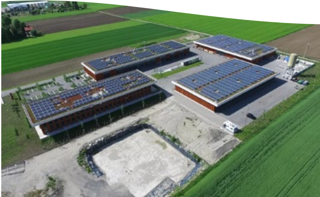
Rechts unten die Kiesgrube. Hier entsteht der innovative Grünstrom-Speicher, der künftig eigenen Sonnenstrom von der 400 kWp-PV-Anlage der Stadtwerke Weilheim zwischenspeichert.
