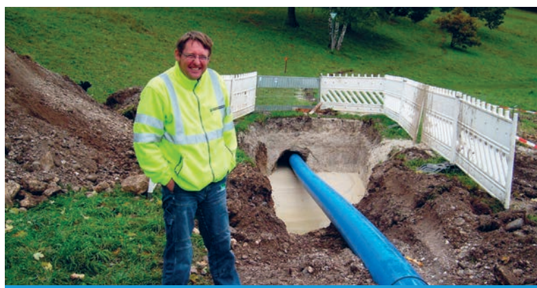
Franz Seiler überwacht das Spülbohrverfahren für den Bau des zweiten großen Wasserrohrs vom Hochbehälter in die Stadt. Es wurde verlegt, um die Weilheimer Trinkwasserversorgung noch sicherer zu machen.
