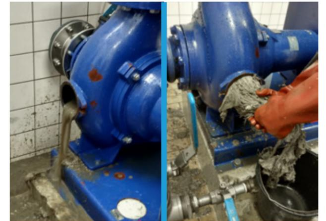
In der Kläranlage der Stadtwerke Weilheim wird eine verstopfte Pumpe geöffnet, Schlamm, Dreck entweicht.
