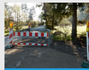
Die Kanalbauarbeiten kurz vor dem Abschluss der Baustelle.
