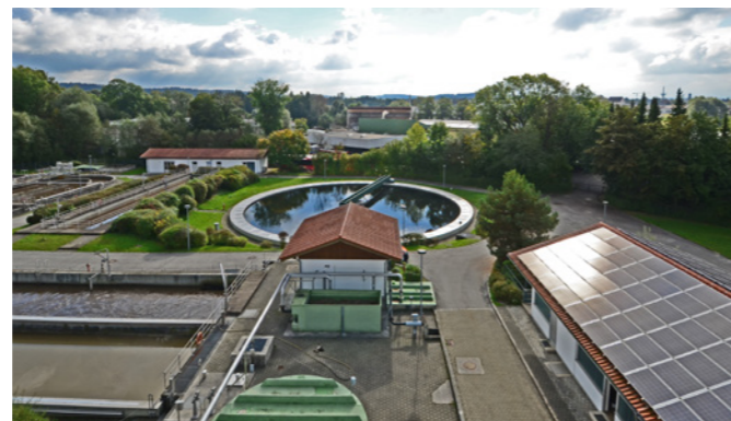
Die Kläranlage der Stadtwerke reinigt Weilheims Abwasser und das dreier Umlandgemeinden - effizient und mit Erneuerbaren Energien aus Wind und Sonne.
