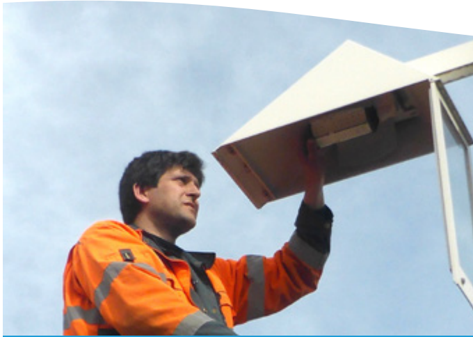
Johann Thalmayr, Elektriker beim Stadtwerke Betriebshof, tauscht alte, energiefressende Natriumdampflampen gegen neue, energiesparende LED Lampen aus.
