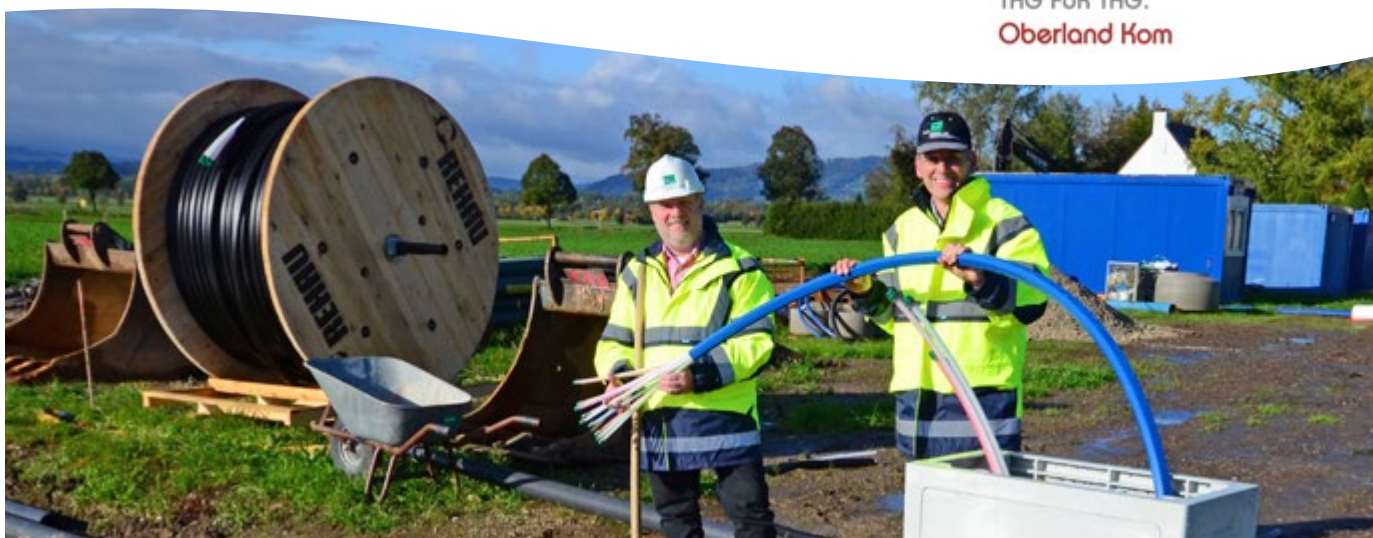
Die SWE startet ein wichtiges Infrastrukturprojekt für Weilheim, das den Bürgern viele Vorteile bringen wird. Spatenstich für die erste Meile für das Giga-schnelle Internet via Glasfaser: SWE Geschäftsführer Peter Müller (links) und SWE Prokurist André Behre.
