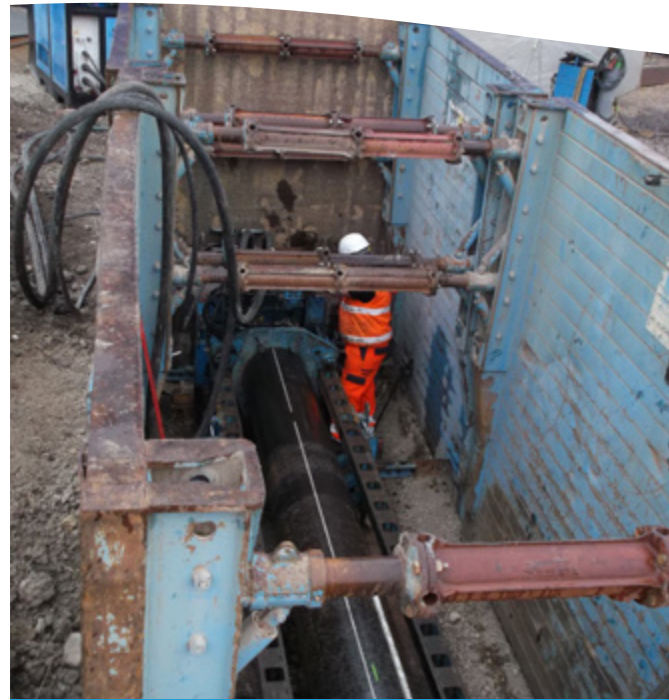
Unter der Bahnstrecke München-Mittenwald beim Bahnübergang Unterhausen erfolgte durch die Stadtwerke Weilheim ein lang geplanter Wasserrohr-Lückenschluss.
