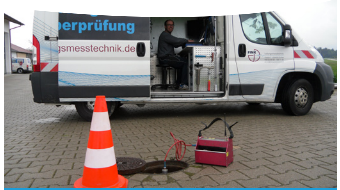
Wenn die Umgebungsgeräusche zu laut oder die Rohre zu tief sind, braucht es eine spezielle Ausrüstung. Sven Karthe von der Fink Leitungsmesstechnik hat am Unterflurhydranten einen Sender vom Korrelator angebracht. Im Messfahrzeug wertet er Daten aus.
