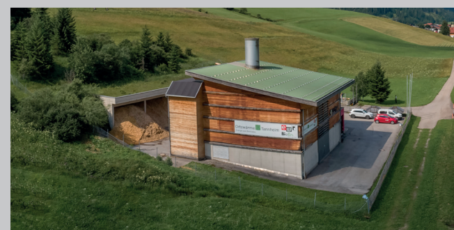
Foto: Ortswärme Tannheim
