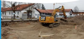
Zwei Spezialfirmen richten die Baustelleninfrastruktur für die Altlastensanierung ein. Dafür stellen sie u.a. Bagger- und Bohrgerät sowie Baucontainer auf
