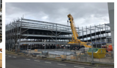
Die Montage des Parkhauses erfolgt in Etappen
