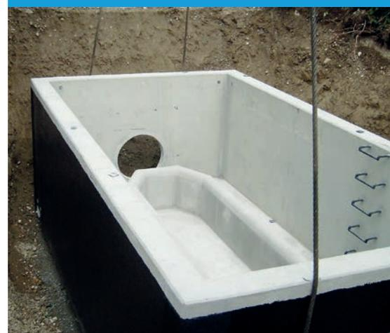
Hier wird ein Regenüberlauf nahe der Ammer eingebaut. Er sorgt dafür, dass bei Starkregen eine definierte Wassermenge in den Vorfluter, die Ammer geleitet wird. Das dient zum Schutz des angrenzenden Gewerbegebietes.
