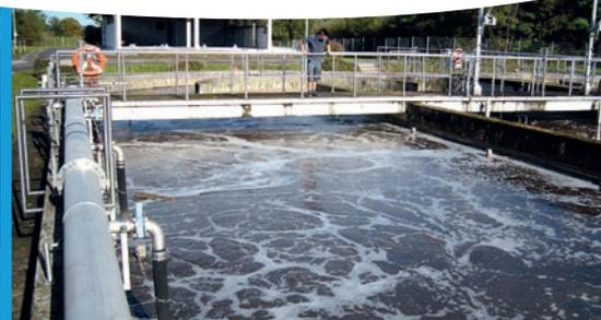
Das Belebungsbecken ist der größte Energiefresser im Klärwerk. Denn Sauerstoff muss zugefügt werden, damit die vielen kleinen Mikroorganismen, die das Abwasser reinigen, Luft zum Atmen und Arbeiten haben.
