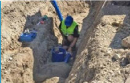
Vor Inbetriebnahme wird die neue Wasserleitung gespült, die Wasserqualität geprüft und Druckprobe gemacht.
